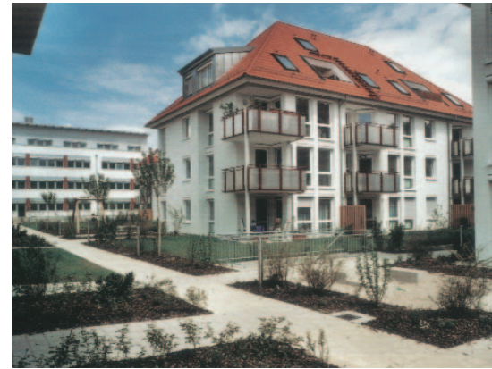
Die Abb. zeigt im Hintergrund das Gebäude der GWG AG in Ludwigsburg.
