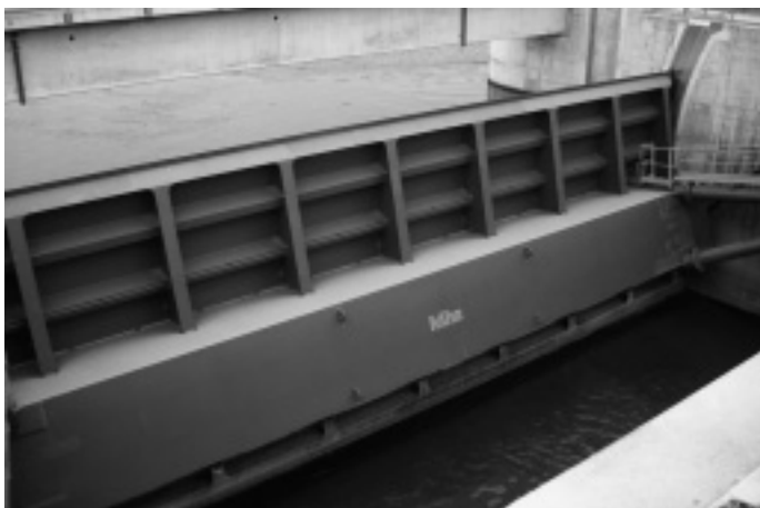
90 Tonnen wiegen die Wehrschützen der Stauwehrfelder (Foto links). Und noch eine Baustelle: Auf der Schweizer Seite entstehen das Maschinenhaus und das letzte von sieben Wehrfeldern.
