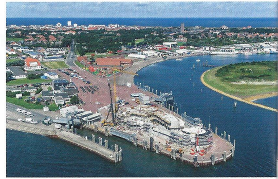
Im Bau: Das Hafenterminal am Nordermeyer Molenkopf.
